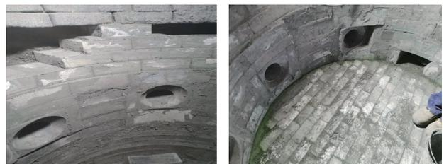
图 4 竖炉烧嘴区域耐火砖改造,采用硫酸灰砌筑
