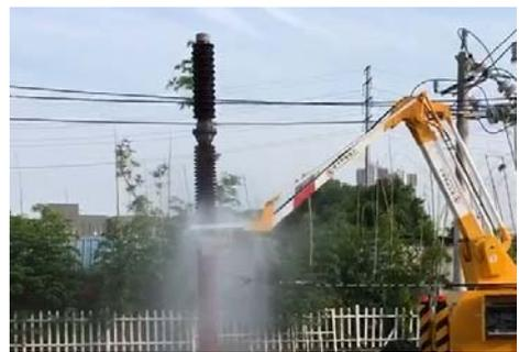
图 5 机器人绝缘子更换作业试验
