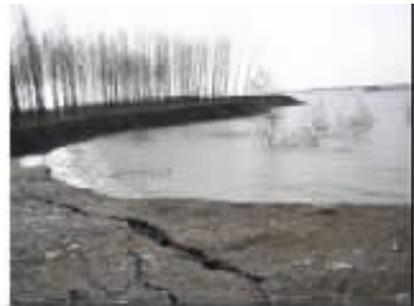
图11 流滑型崩岸示例
