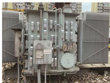
图 14 动力吸振器现场安装照
