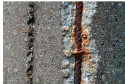
图1 混凝土钢筋锈蚀
